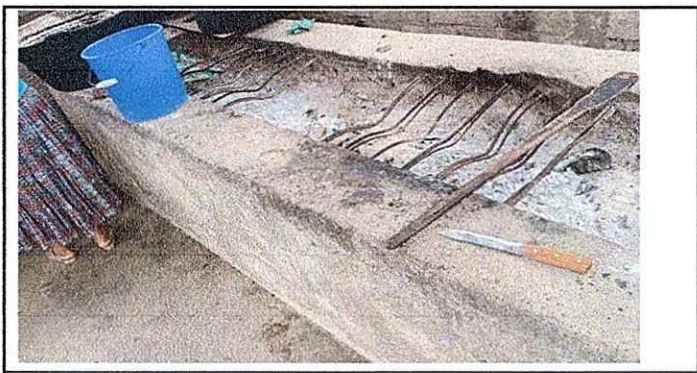
Foto 5: REPARACIÓN DE POLLETON
